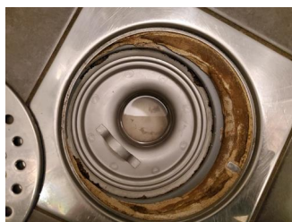
Tettesjiktets tilslutning til sluk - Sluk
