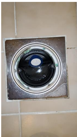
Våtrom - [Sluk bad]
