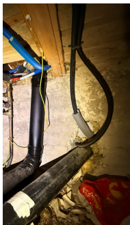
Utsparing i grunnmuren, for gjennomføring av avløpsrør.
