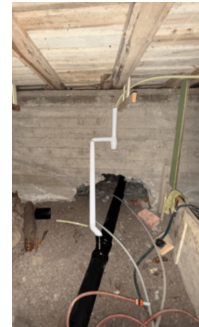
Utsparing i grunnmuren, for gjennomføring av avløpsrør.
