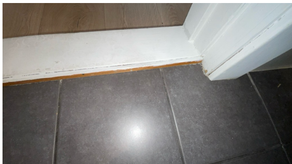
Overgang ved dørterskel.
