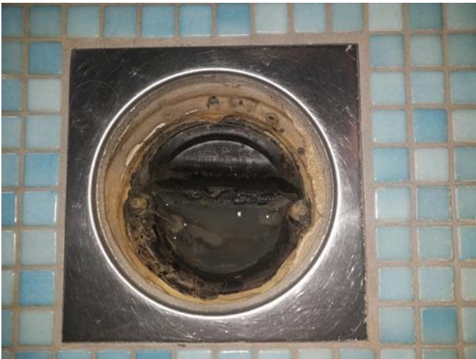
Membran, tettesjikt og overgang til sluk. - [Sluk bad i 2.etasje.]
