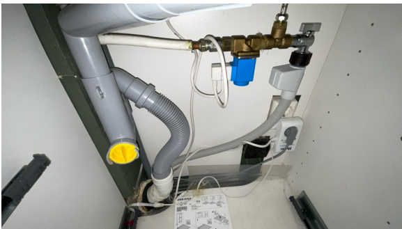
Nyere vannrør og lekkasjestopp på kjøkken.
