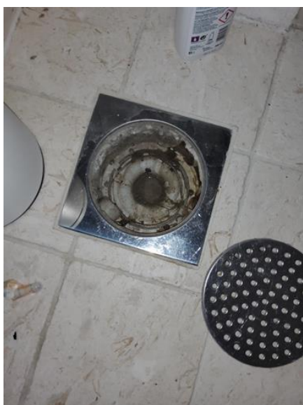
Membran, tettesjikt og overgang til sluk. - [Hovedsluk Baderom 2.etasje, ved toalett.]
