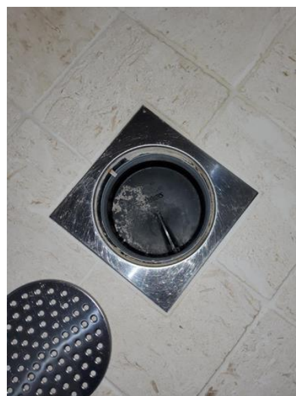
Membran, tettesjikt og overgang til sluk. - [Hjelpesluk Baderom 2.etasje, i dusjhjørne. ]
