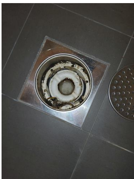
Membran, tettesjikt og overgang til sluk. - [Sluk Baderom 3.etasje.]
