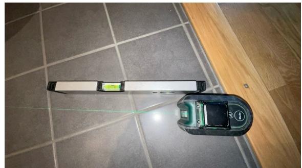
Fallforhold målt i retning sluk.
