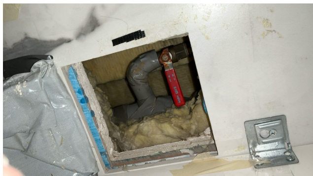
Åpning i vegg bak servant for tilkomst hovedstoppekran.
