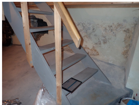
For store åpninger i rekkverk til kjeller
