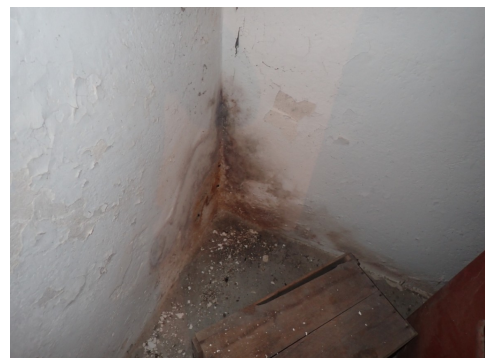
Stedvis saltutslag i kjeller gulv
