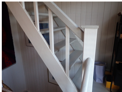
For store åpninger i rekkverk til kjeller
