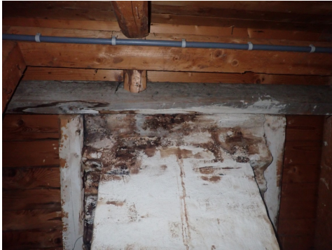
Det er påvcist skjolder i undertak ved pip
