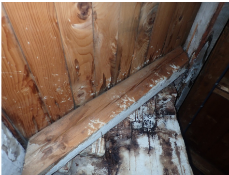
Det er påvcist skjolder i undertak ved pip
