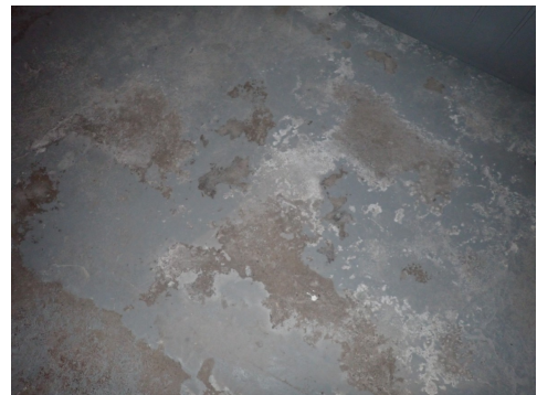
Stedvis saltutslag i kjeller gulv
