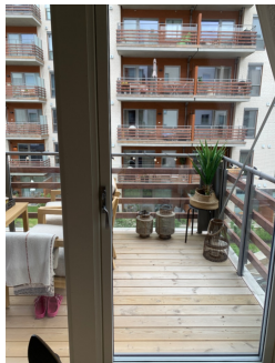
Balkongdør med malt tre ramme
