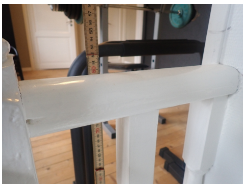
Høyde rekkverk ca. 80 cm.
