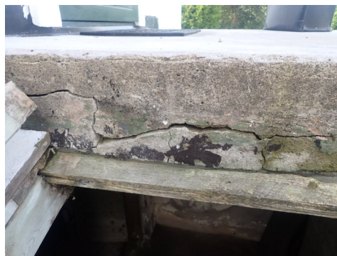
Betonggulv har sprekker
