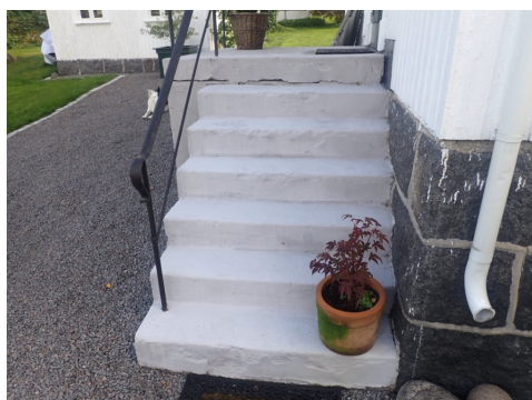
Støpt trapp til inngangsparti.
