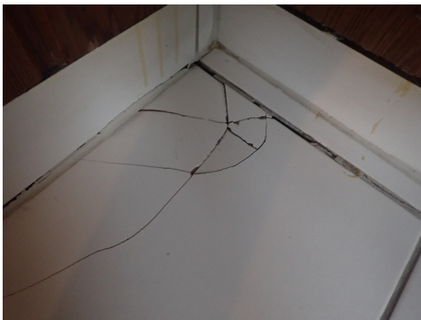
Flere fliser på gulv har sprukket.
