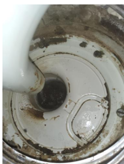
Tettesjiktets tilslutning til sluk - Sluk
