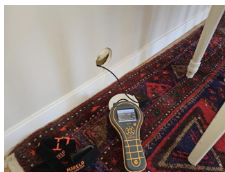
Utført kontroll i tilliggende konstruksjon - Fuktmåling.
