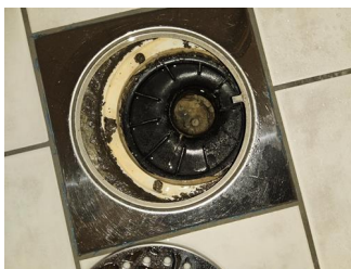
Tettesjiktets tilslutning til sluk - Sluk, bad.
