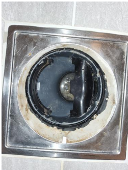
Tettesjiktets tilslutning til sluk - Sluk bad
