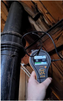
Synlige overflater (taktro, vegger, gulv, o.l.) - Fuktmåling med pigg undertak
