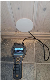
Kontroll i lukkede konstruksjoner - Fuktmåling
