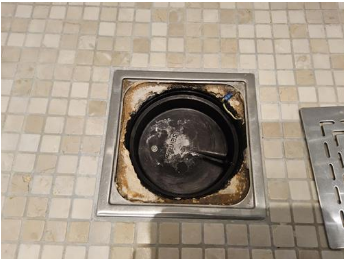
Membran, tettesjikt og overgang til sluk. - [Sluk ]
