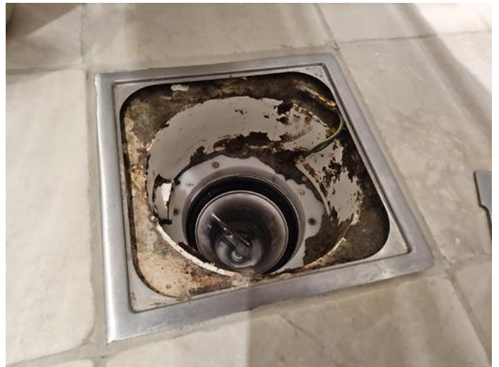
Membran, tettesjikt og overgang til sluk. - [Sluk ]
