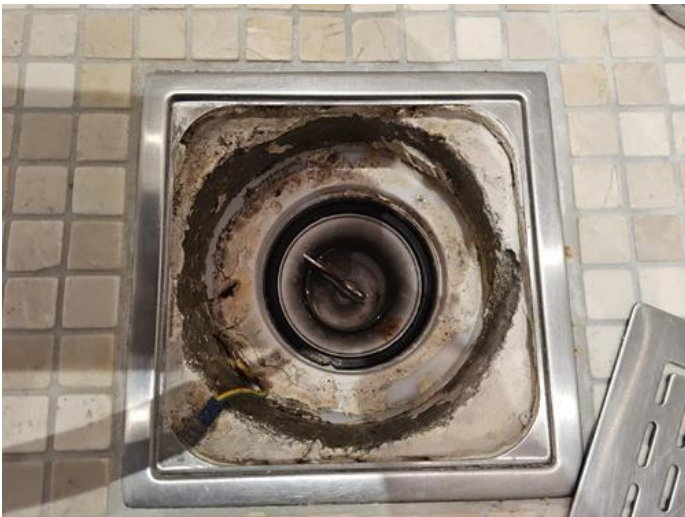
Membran, tettesjikt og overgang til sluk. - [Sluk]
