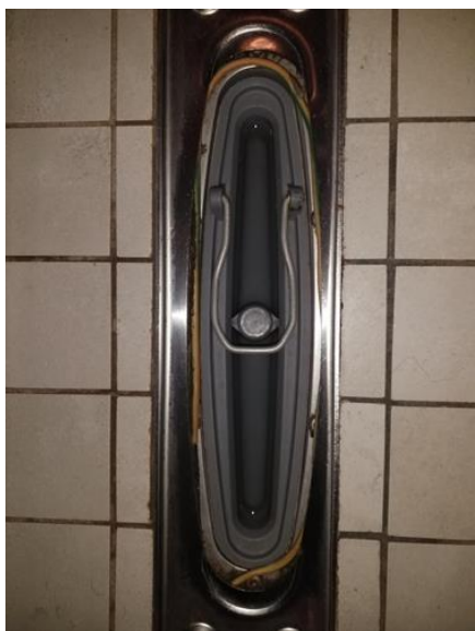
Membran, tettesjikt og overgang til sluk. - [Sluk bad i loftsetasje. ]
