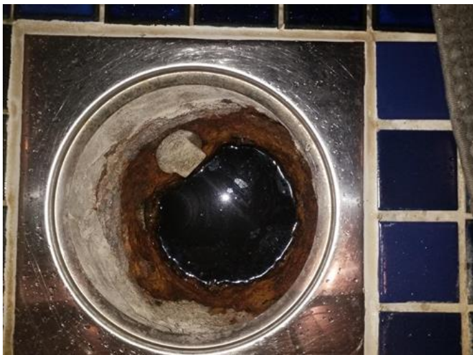
Membran, tettesjikt og overgang til sluk. - [Hovedsluk i 6.etasje. ]
