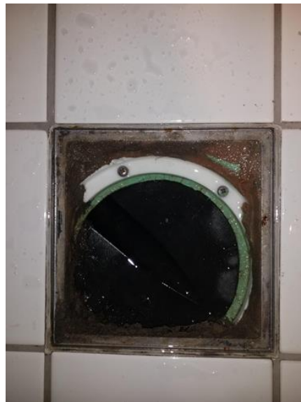
Membran, tettesjikt og overgang til sluk. - [Hjelpesluk i dusjsone i 6.etasje. ]
