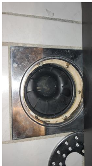
Våtrom - [Sluk bad 1. etasje]
