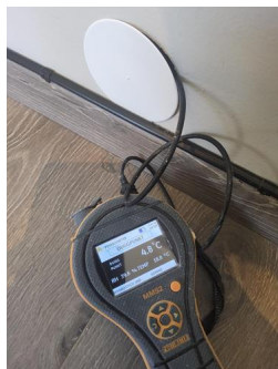
Utført kontroll i tilliggende konstruksjon - Fuktmåling
