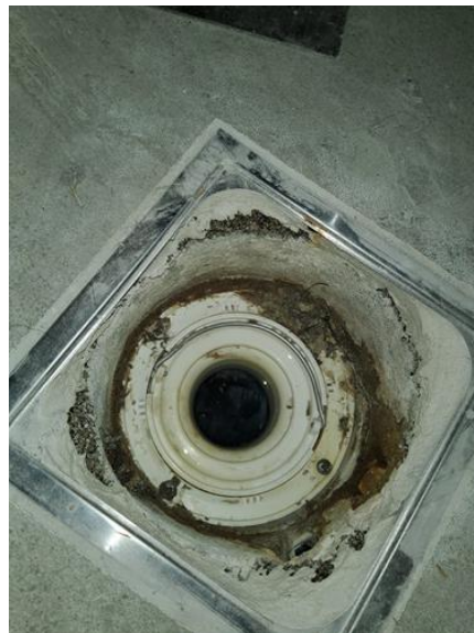
Membran, tettesjikt og overgang til sluk. - [Sluk]
