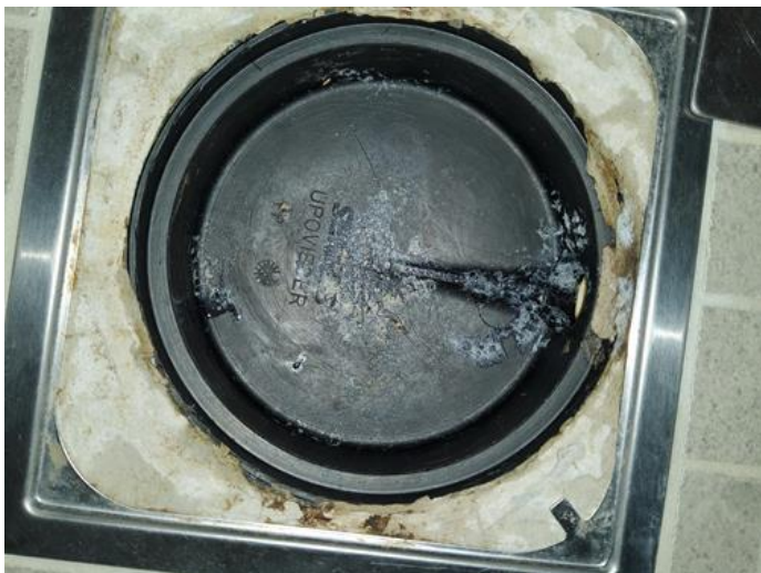
Membran, tettesjikt og overgang til sluk. - [Hjelpesluk]
