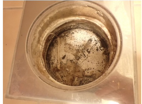
Sluk på gulv med avløpp til sluk i dusj.
