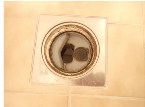
Sluk på gulv med avløpp til sluk i dusj.
