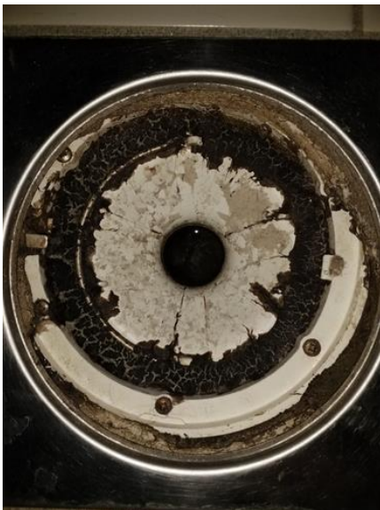
Membran, tettesjikt og overgang til sluk. - [Sluk bad hybel]
