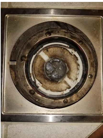
Membran, tettesjikt og overgang til sluk. - [Sluk bad kjeller hoveddel]
